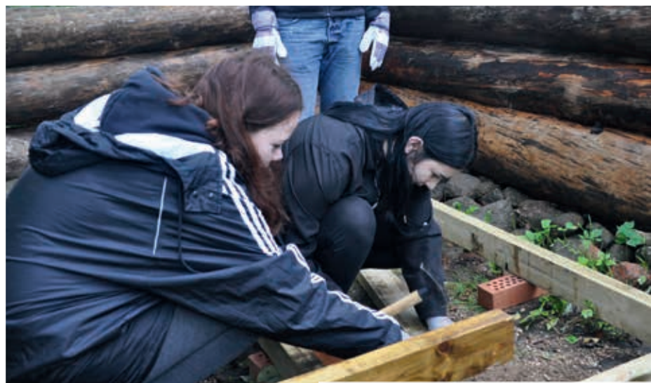
Grillplatz: Grundgerüst wird erstellt
